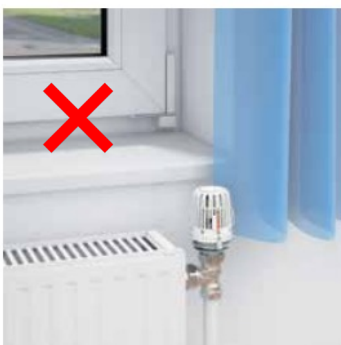
Špatně: Termostatická hlavice s vestavěným čidlem nesmí být osazena do svislé polohy.
